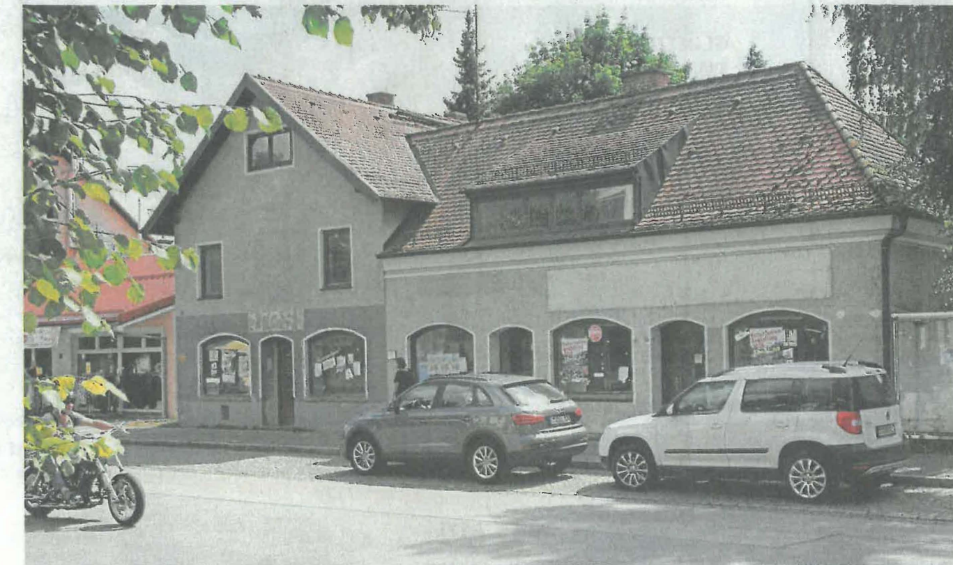
Die Tage sind gezählt: Das Bestandsgebäude soll noch in diesem Jahr verschwinden.
